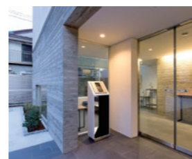
ディアコート入り口横、杉板模様のコンクリートの外壁
