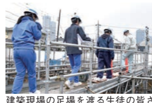
建築現場の足場を渡る生徒の皆さん(今井中)
