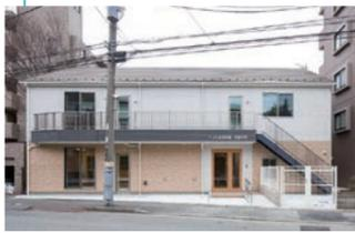
2018年3月23日、中原区上小田中に完成した木造2階建て保育園です。立地条件等を考慮し、防音性・保温性・調湿性に優れた断熱材セルロースファイバーを使用しています。
