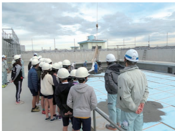
屋上プールの工事の様子に興味津々
