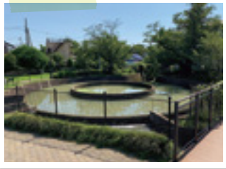
久地田筒分水
