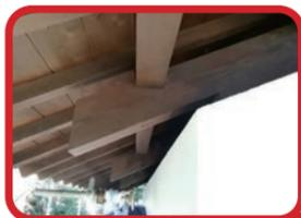
屋根は壊れた部分の補修と、瓦が飛ばないように補強しました。軒下は通気性を考えた作りになっています。
