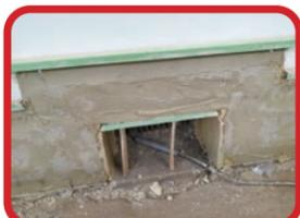
耐久性のある土佐漆喰は、主に石灰と発酵させた糞で作る自然素材の材料です。劣化するノリは使わず、メッシュを間に挟むことで、土台を補強しています。
