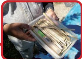
鉄釘は使わず、竹釘に麻の紐を巻き付けて平壁に差し込んで壁を補強。仕上げに無機塗料で汚れをつきにしています。
