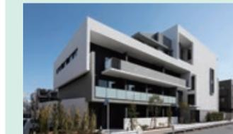
2023年2月7日、中原区下小田中に完成した、延床面積2,098.10㎡、RC造5階建て1K×19戸、2LDK×15戸、3LDK×1戸の共同住宅です。
