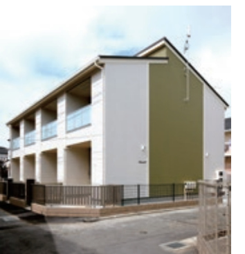
明るい外壁にさわやかな「わさび色」をアクセントにした「シャムロック」
